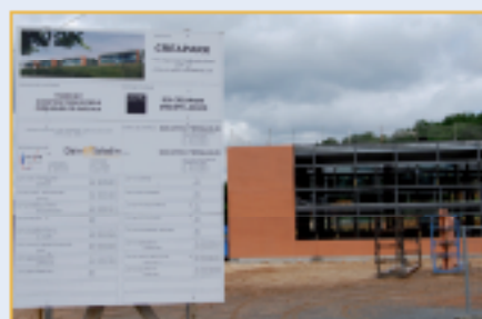
Les immeubles de bureaux construits par le groupe Lazard sortent de terre près de la Pépinière cap@cités et seront livrés à l'automne.
