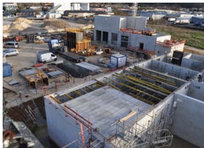
Les planchers de la nouvelle station d'épuration de Boulazac ont débuté.
